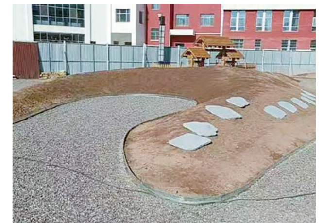
敷砂利と飛石配置状況
