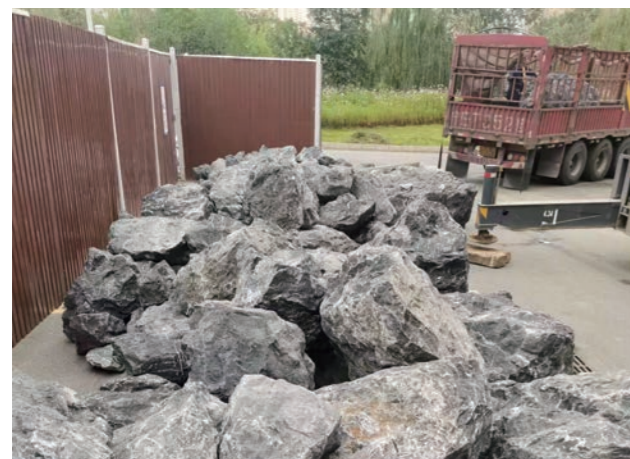
現場に搬入された石材、形状、石質ともによく揃っている。
