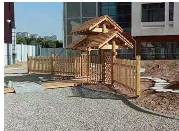
正面入口庭門と板塀設置
