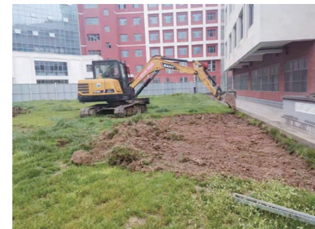
すき取り、整地状況
